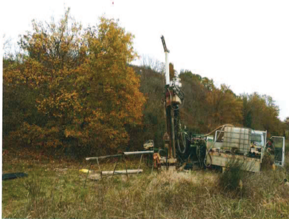
Foto n° 8 – Ubicazione Sondaggio geognostico
