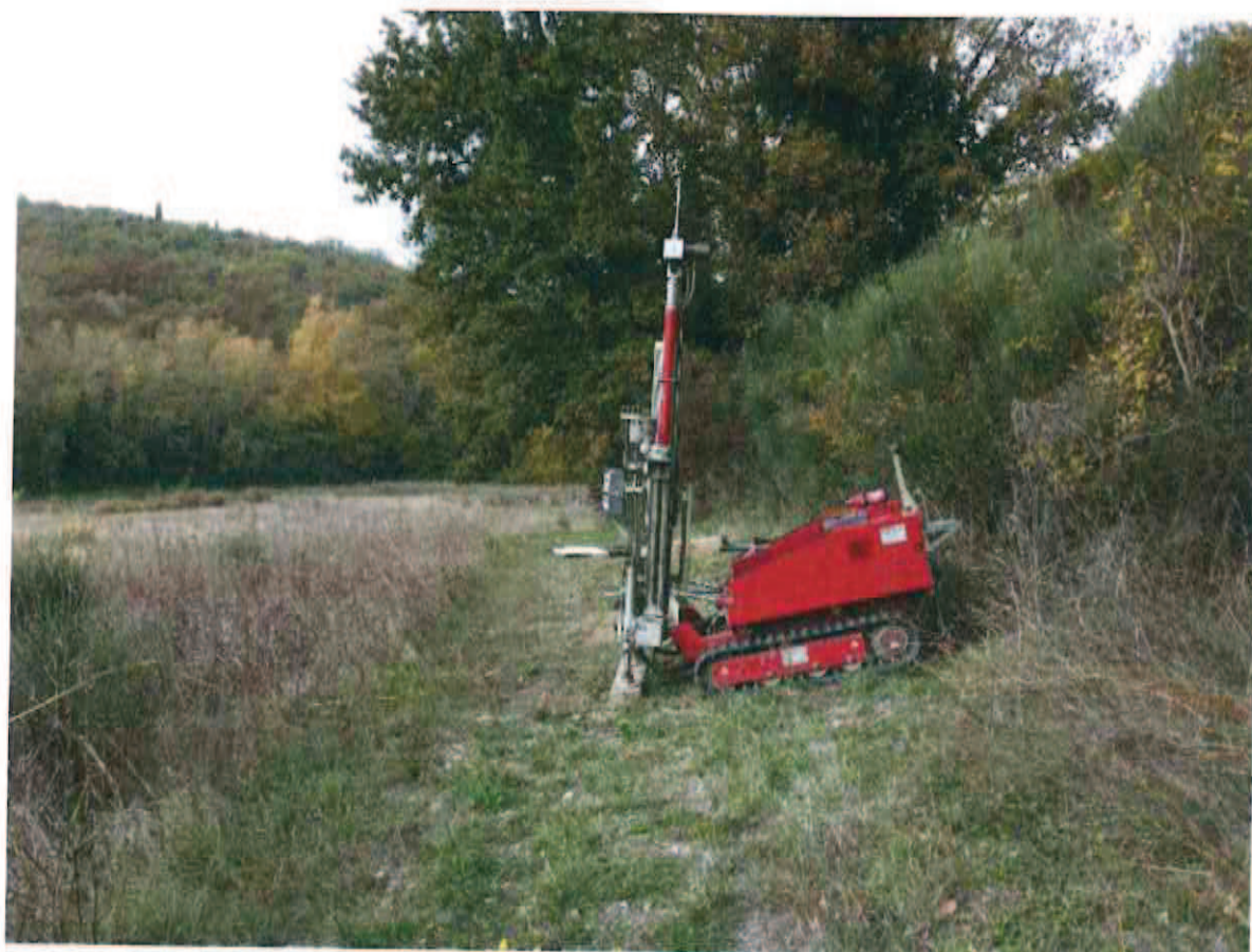
Foto n° 5 – Ubicazione penetrometria n° 2
