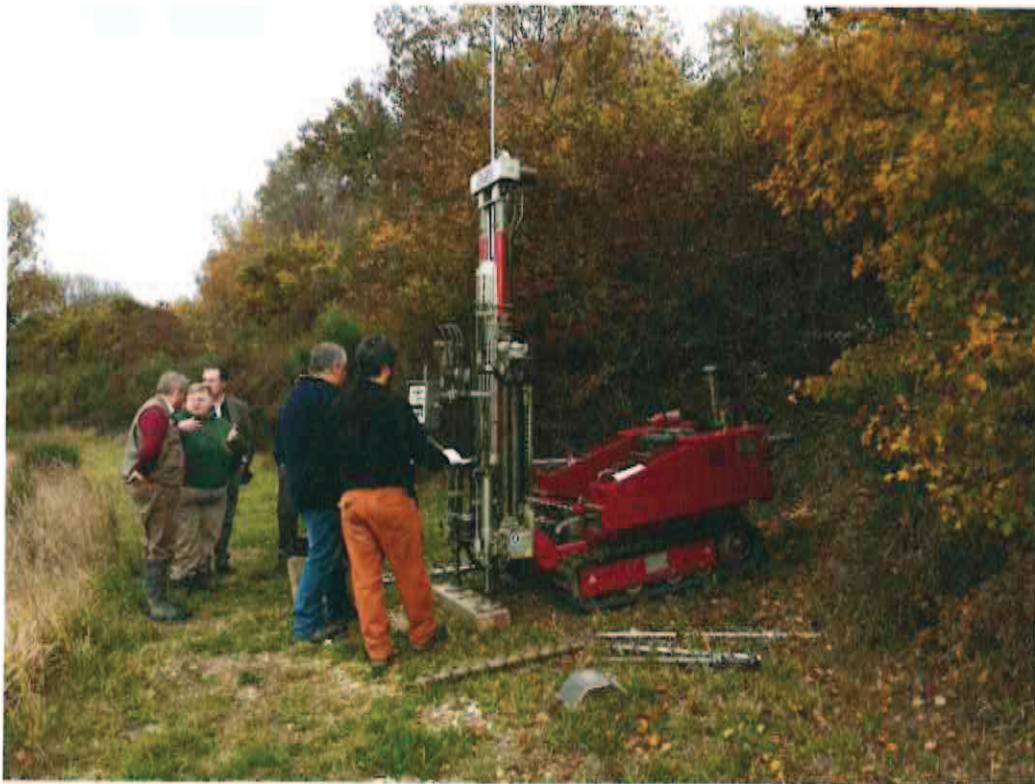
Foto n° 4 – Ubicazione penetrometria n° 1
