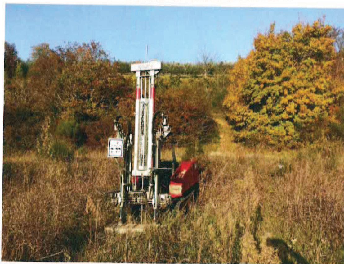
Foto n° 6 – Ubicazione penetrometria n° 3
